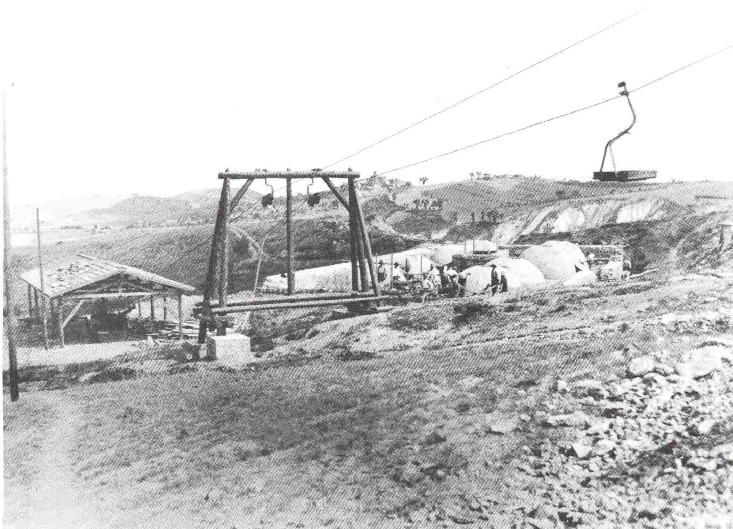
*La miniera di Valdinoco. Teleferica per il trasporto del materiale ed edificio in costruzione per la copertura dei forni Gill.
