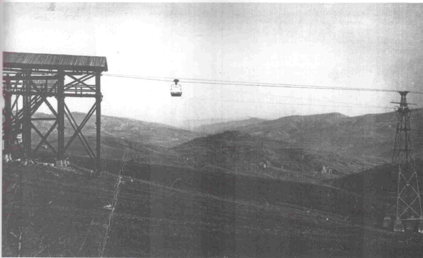
Uno scorcio della teleferica che trasportava zolfo greggio dalla miniera alla raffineria di Bellisio.
