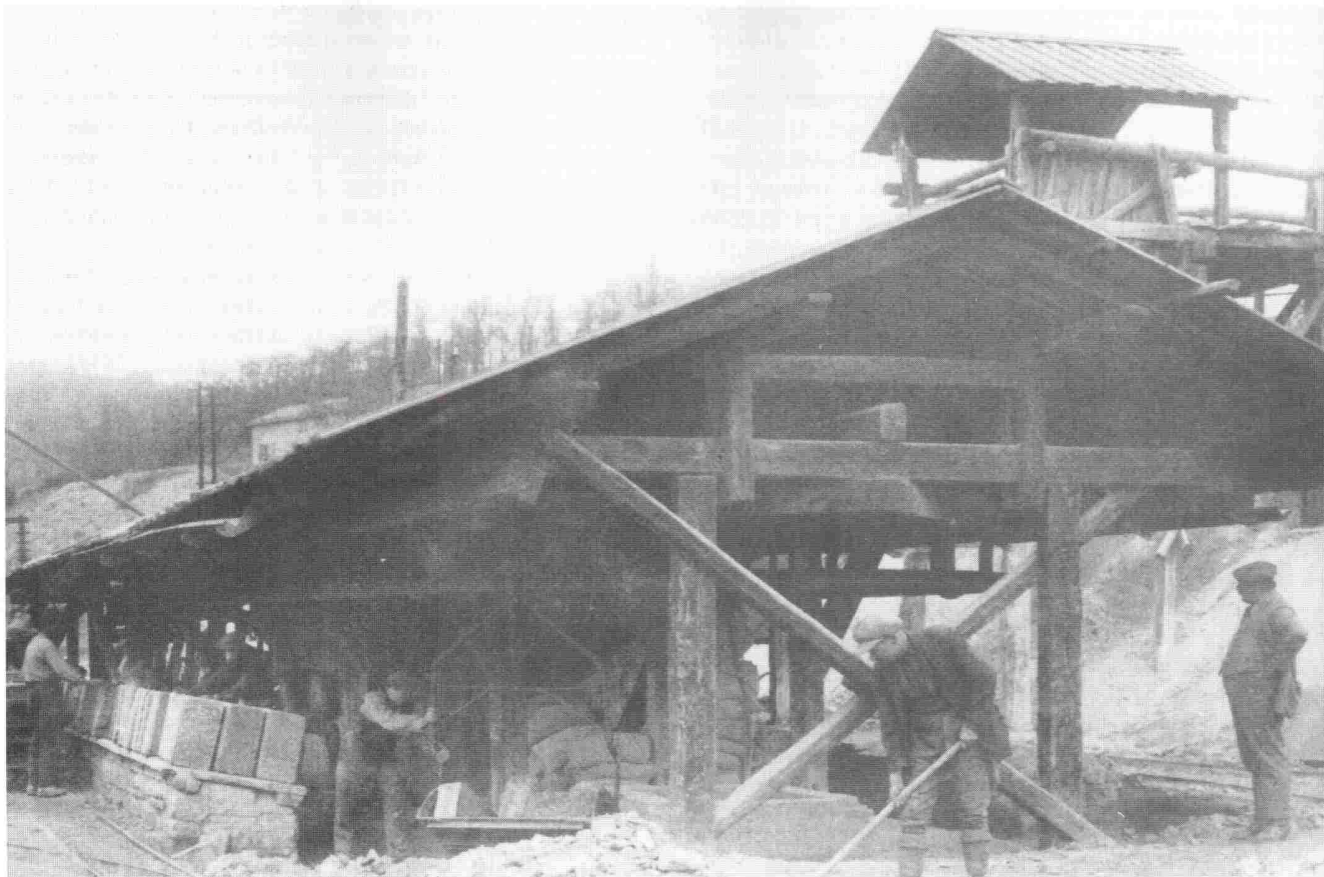
Stazione di partenza della teleferica verso la raffineria di Bellisio. Si caricano i pani di zolfo.
