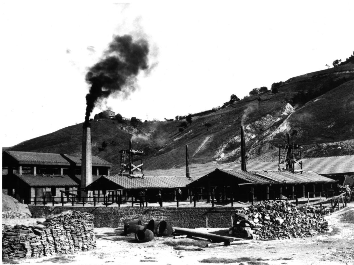
Miniera di Formignano, 1904-1906. Le prime quadriglie di Forni Gill in funzione; a sinistra il capannone dei doppioni-Fondo G:Brasa Biblioteca Malatestiana Cesena.
