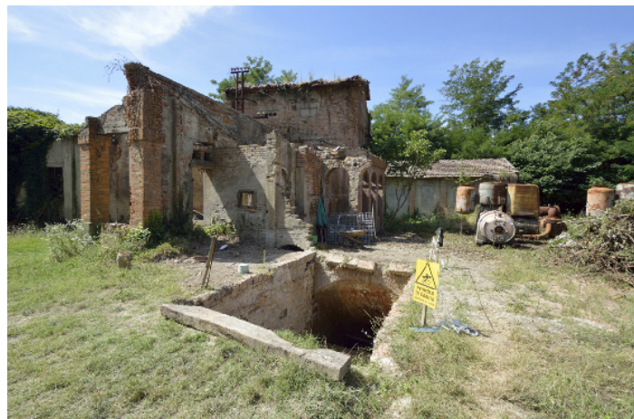
Il piazzale della discenderia oggi: al centro la ripida discesa che porta all'ingresso della discenderia (50° di inclinazione); sulla destra la lampisteria, ripulita dalle piante infestanti che quasi la nascondevano alla vista.
