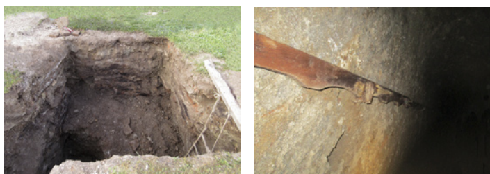
Piazzale della discenderia oggi: l'apertura del pozzo Alessandro; il corrimano della scala che parte dalla loggetta della lampisteria
