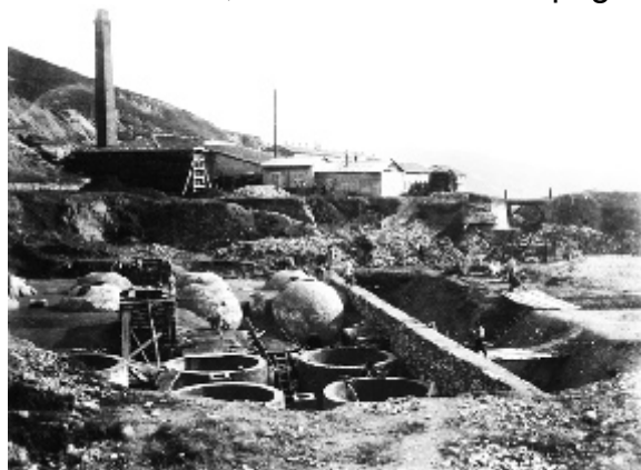
Fig. 12 - Forni Gill in costruzione Ad opera avvenuta le celle restano sepolte nel terreno
