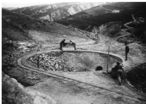
Fig. 11 - Riempimento di un calcarone - A destra scorgesi il lembo di un altro già fornato
