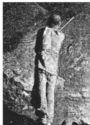
fig. 6 - operaio che pratica un foro per la mina
