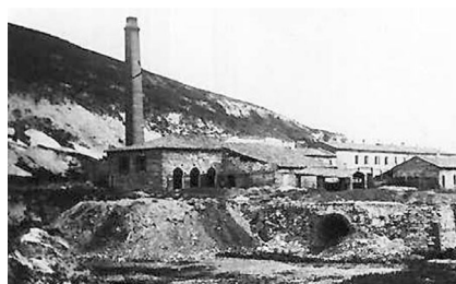
Primi dei 1900: costruzione dei forni Gill a Formignano
