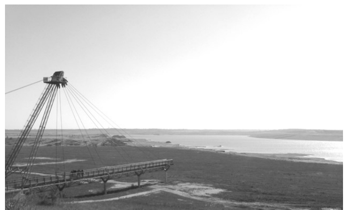
Ex miniera a cielo aperto in corso di riempimento
