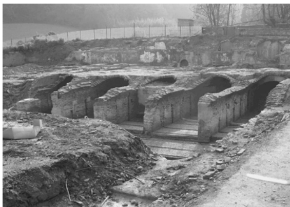
Condotte forzate del molino Palazzo
