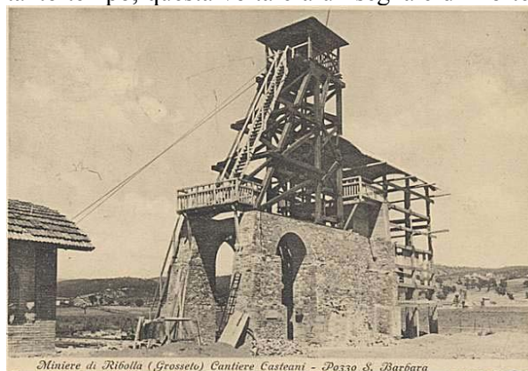
Miniere di Ribolla (Grosseto) Cantiere Castoani - Pozzo S. Barbara
