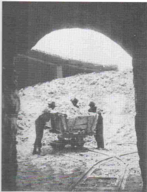
Carreggiatori all'uscita di una galleria
