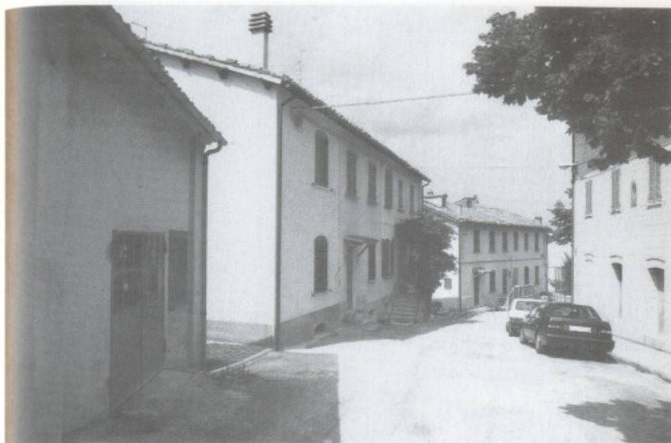
4. Cabernardi, abitazioni ex impiegati della miniera, 1996.
