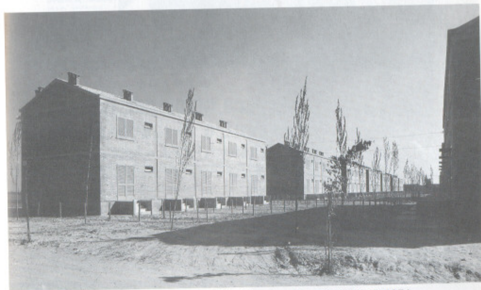
9. Pontelagoscuro, case del villaggio a lavori conclusi, 1954.
