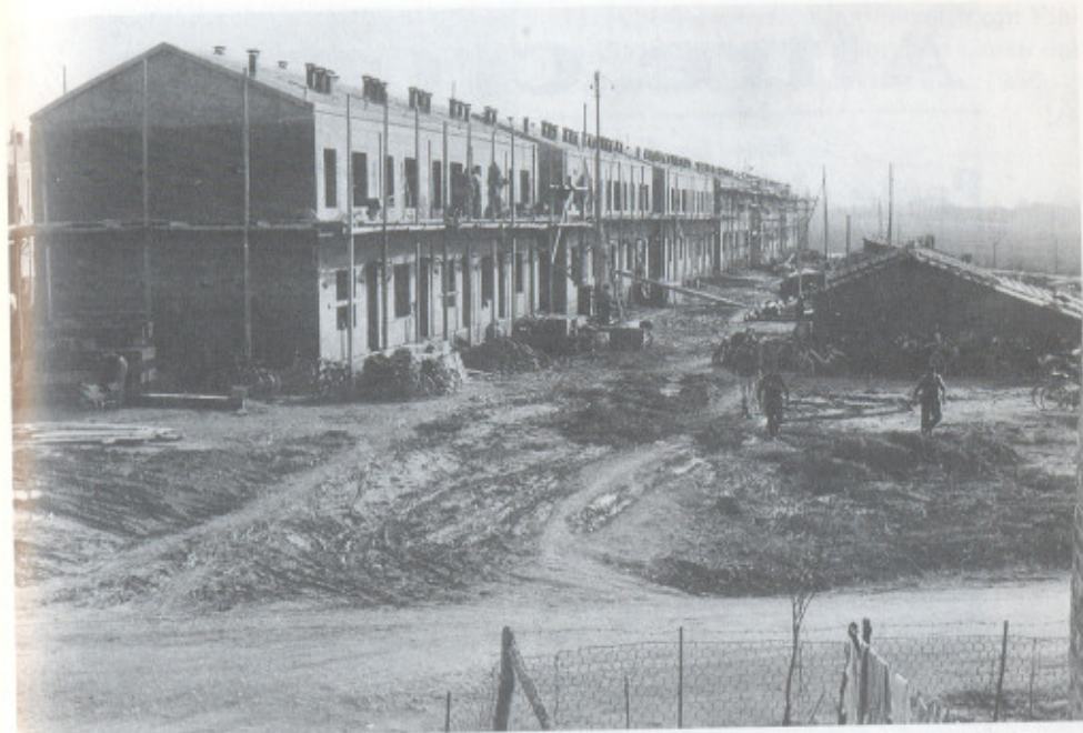
8. Pontelagoscuro, primo blocco delle case del Villaggio in costruzione, 1953-54.
