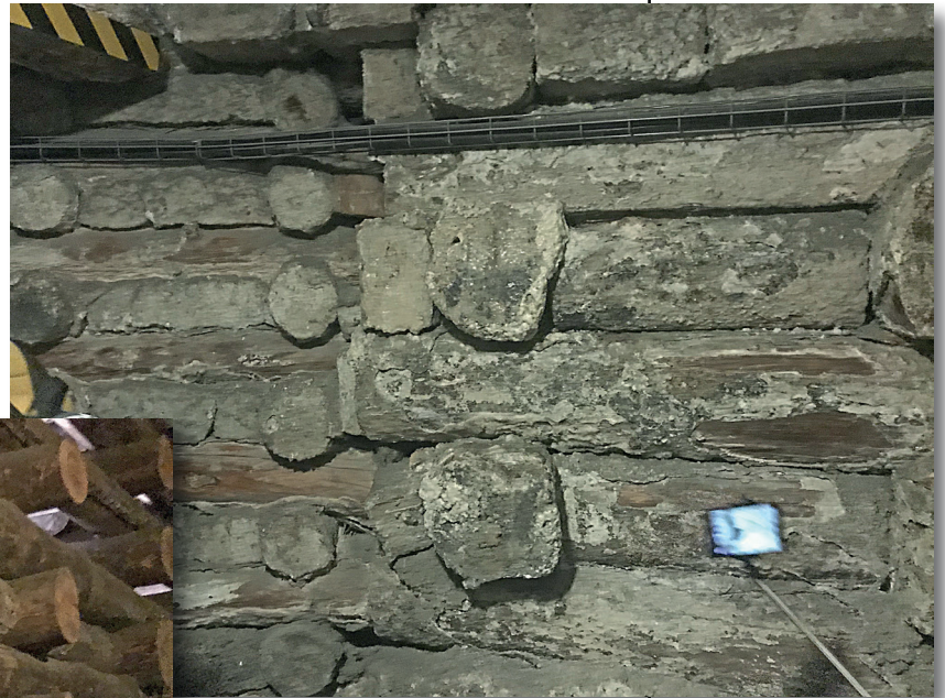
nelle immagini: qui sopra tronchi di larice ricoperti di sale risalenti al 1500; a lato la struttura in legno di larice per consolidare le pareti saline.
